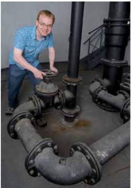
Matthias Borner im Wasserturm.
